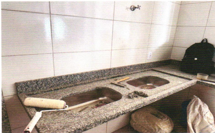
FOTO 206: INSTALAÇÃO CUBA INOX
