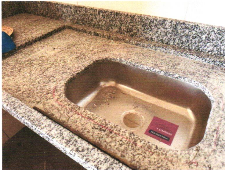
FOTO 204: INSTALAÇÃO CUBA INOX
