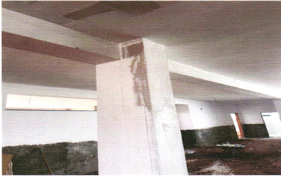
FOTO 201: PAREDE DE DRYWALL
